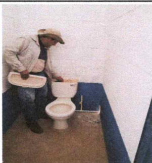
Foto1: se les instala agua a los baños así como cambio de accesorios y tubería de drenaje que se encontraba en malas condiciones.
