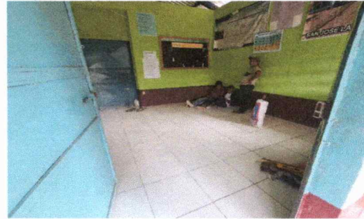
Foto 8: Se remozo el piso de la direccion del establecimiento.
