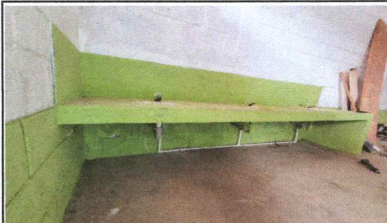
Foto 2: también se empezó a remodelar los lavamanos del baño de preprimaria y de los módulos de primaria.
