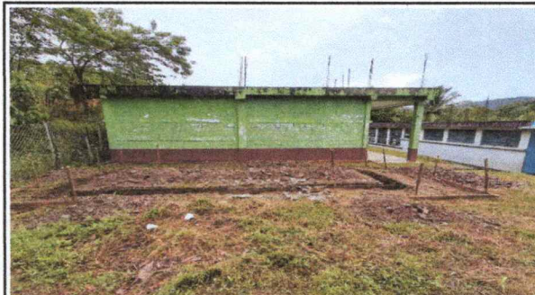
Foto 4: se encontró con la necesidad de realizar una base para tinacos ya que la terraza del establecimiento está hecha con block y el albañil dijo que no aguantaría el peso de los mismos.
