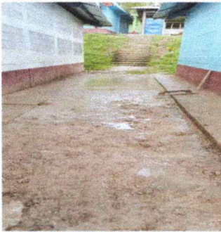
Foto 9: Se priorizo tirar losa de patio en el camino al comedor ya que esta parte juntaba mucha agua y lodo, siendo un peligro para el transitar de los niños.
